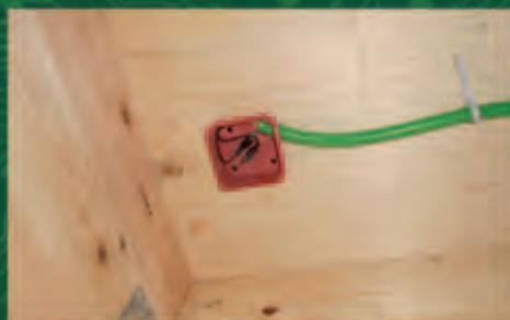
Nell'edificio è stato installato, in collaborazione con FEDERLEGNOARREDO, un sofisticato sistema di monitoraggio per controllare l'umidità dei setti portanti in legno al fine di ottimizzare l'utilizzo e la manutenzione del fabbricato.
