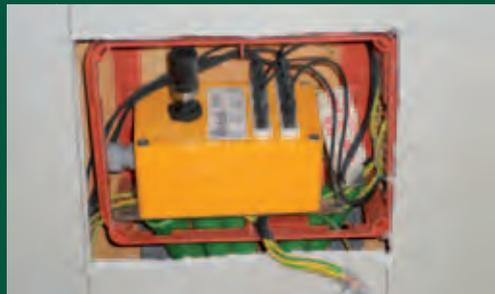
Nell'edificio è stato installato, in collaborazione con FEDERLEGNOAR REDO, un sofisticato sistema di monitoraggio per controllare l'umidità dei setti portanti in legno al fine di ottimizzare l'utilizzo e la manutenzione del fabbricato. L'edificio è così la prima opera in Europa realizzata in legno X LAM ad avere un simile impianto di monitoraggio. Tale sistema, ideato da FederlegnoArredo, è stato di recente brevettato e consente di visionare il battito cardiaco dell'edificio,
