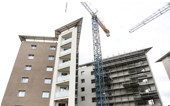
Il 14 giugno 2017 è stato completato il montaggio delle pareti e dei solai in legno XLAM dei 6 corpi di fabbrica costituenti i due edifici dell'intervento.
