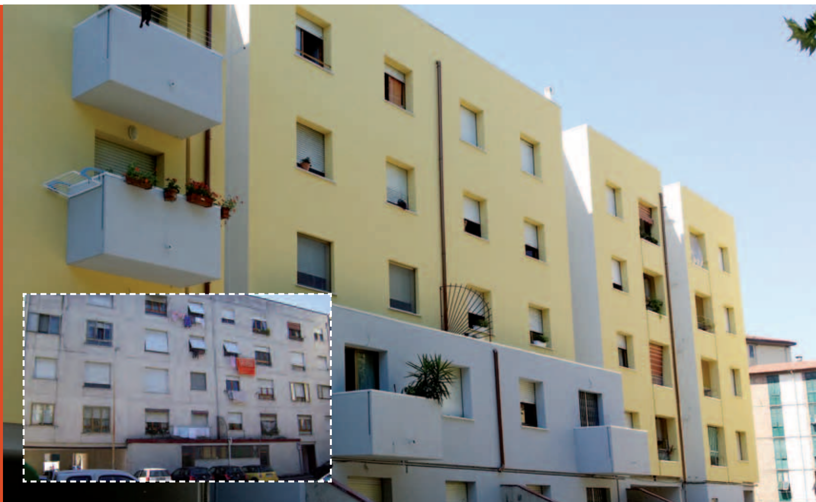
Firenze, via Valdombro: intervento di efficientamento energetico con coibentazione a cappotto
