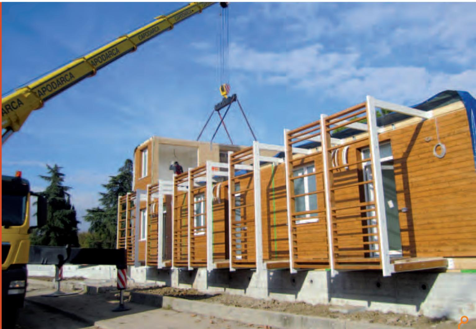
Il montaggio, in corso, degli alloggi volano, prefabbricati in legno, montabili e smontabili a Firenze, viale Guidoni
