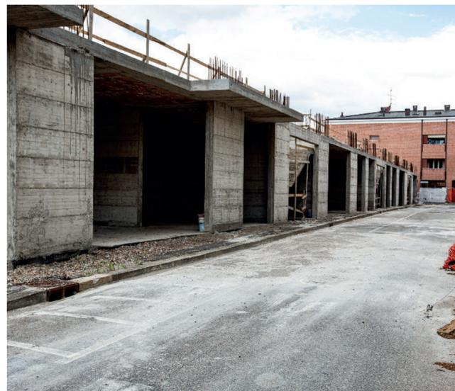
Nel gennaio 2021 sono terminate le opere relative allo stralcio III (fondazioni ed opere in cemento armato relative ai piani terra e primo). È in fase di finalizzazione la progettazione esecutiva dello stralcio IV (completamento delle
