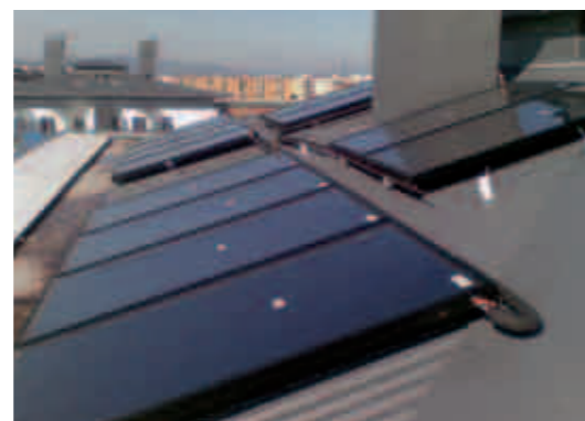
I PANNELLI RADIANTI ALL'INTERNO DI UN APPARTAMENTO DURANTE L'INSTALLAZIONE A SINISTRA: LA CASSETTA DI CONTABILIZZAZIONE CON CONTACALORIE, CONTATORE DI ACQUA CALDA E FREDDA SANITARIA SOTTO: I PANNELLI SOLARI PER LA PRODUZIONE DI ACQUA CALDA SANITARIA E, A SINISTRA, I PANNELLI FOTOVOLTAICI PER LA PRODUZIONE DI ENERGIA ELETTRICA AD USO CONDOMINIALE
