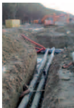
A SINISTRA: LA CENTRALE DI COGENERAZIONE A BIOMASSE E LA RETE DI TELERISCALDAMENTO DURANTE LA REALIZZAZIONE SOPRA: LA SOTTOCENTRALE DI DIETROGGIO
