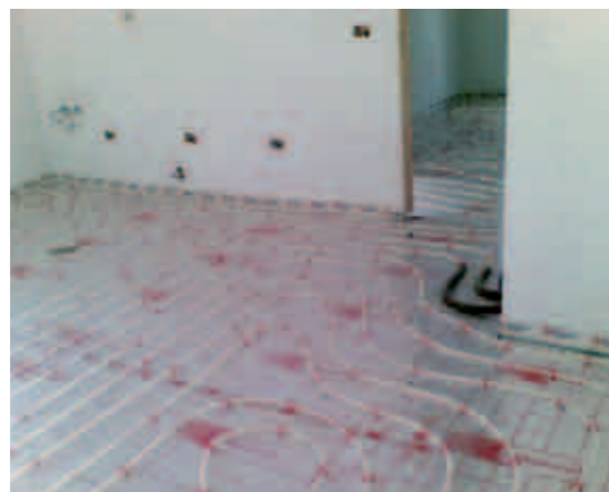
I PANNELLI RADIANTI ALL'INTERNO DI UN APPARTAMENTO DURANTE L'INSTALLAZIONE A SINISTRA: LA CASSETTA DI CONTABILIZZAZIONE CON CONTACALORIE, CONTATORE DI ACQUA CALDA E FREDDA SANITARIA SOTTO: I PANNELLI SOLARI PER LA PRODUZIONE DI ACQUA CALDA SANITARIA E, A SINISTRA, I PANNELLI FOTOVOLTAICI PER LA PRODUZIONE DI ENERGIA ELETTRICA AD USO CONDOMINIALE
