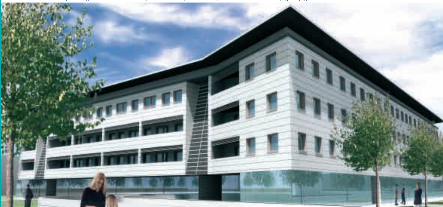
L'intervento residenziale del contratto di Quartiere II "La Porta del Parco" a Calenzano (FI)
