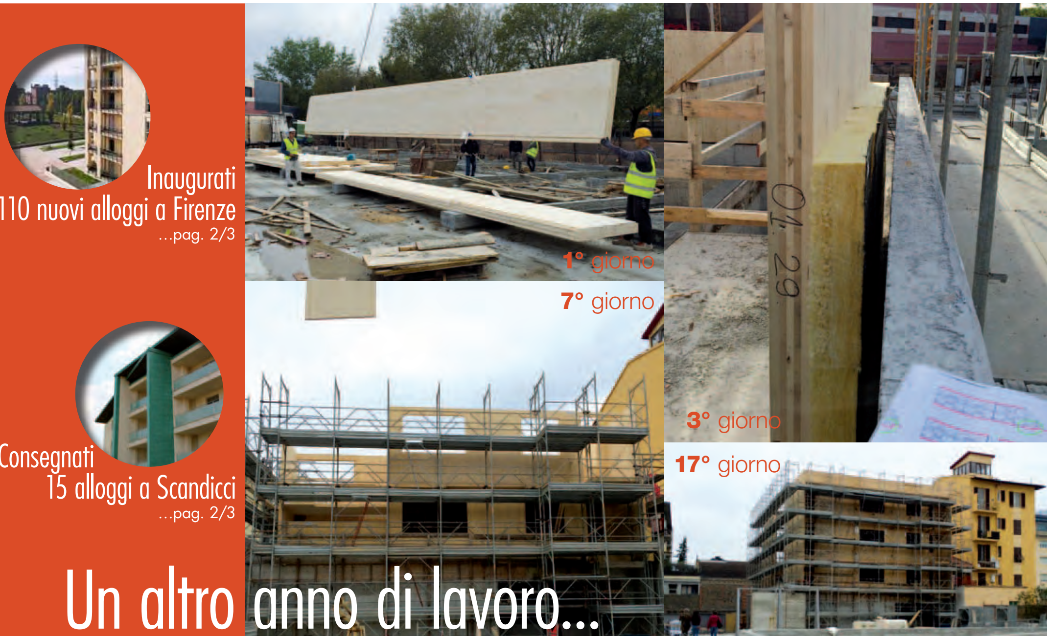
Fasi della cantierizzazione dei 6+39 alloggi e.r.p. nell'area ex Longinotti a Firenze: edificio per 6 alloggi montato in 17 giorni
