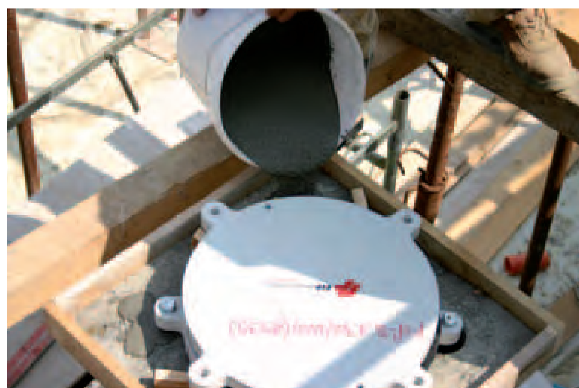
Sopra da sinistra: messa in bolla, pulizia dei fori di ancoraggio; getto
