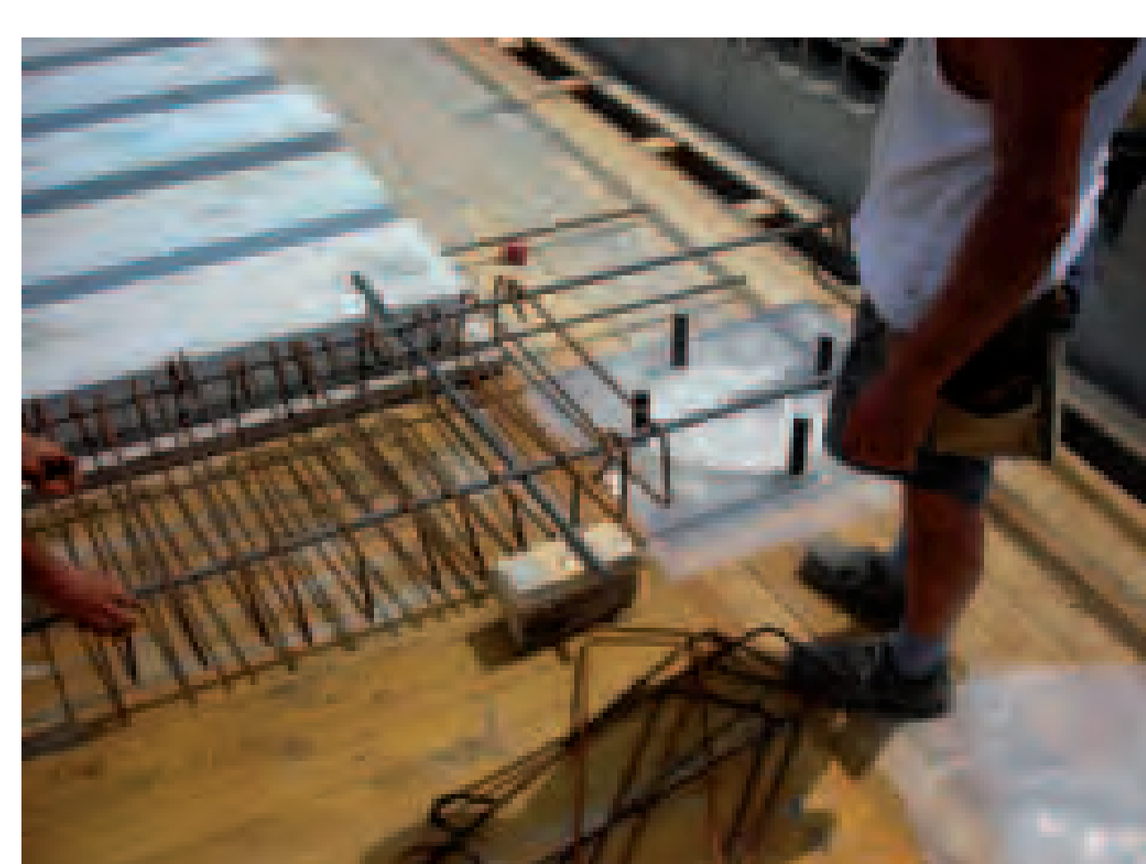
Sopra e a destra: montaggio delle lastre del solaio; realizzazione del cassero "a misura"; posa in opera delle armature; vista dell'appoggio nei locali interrati, una volta rimossi i fermi
