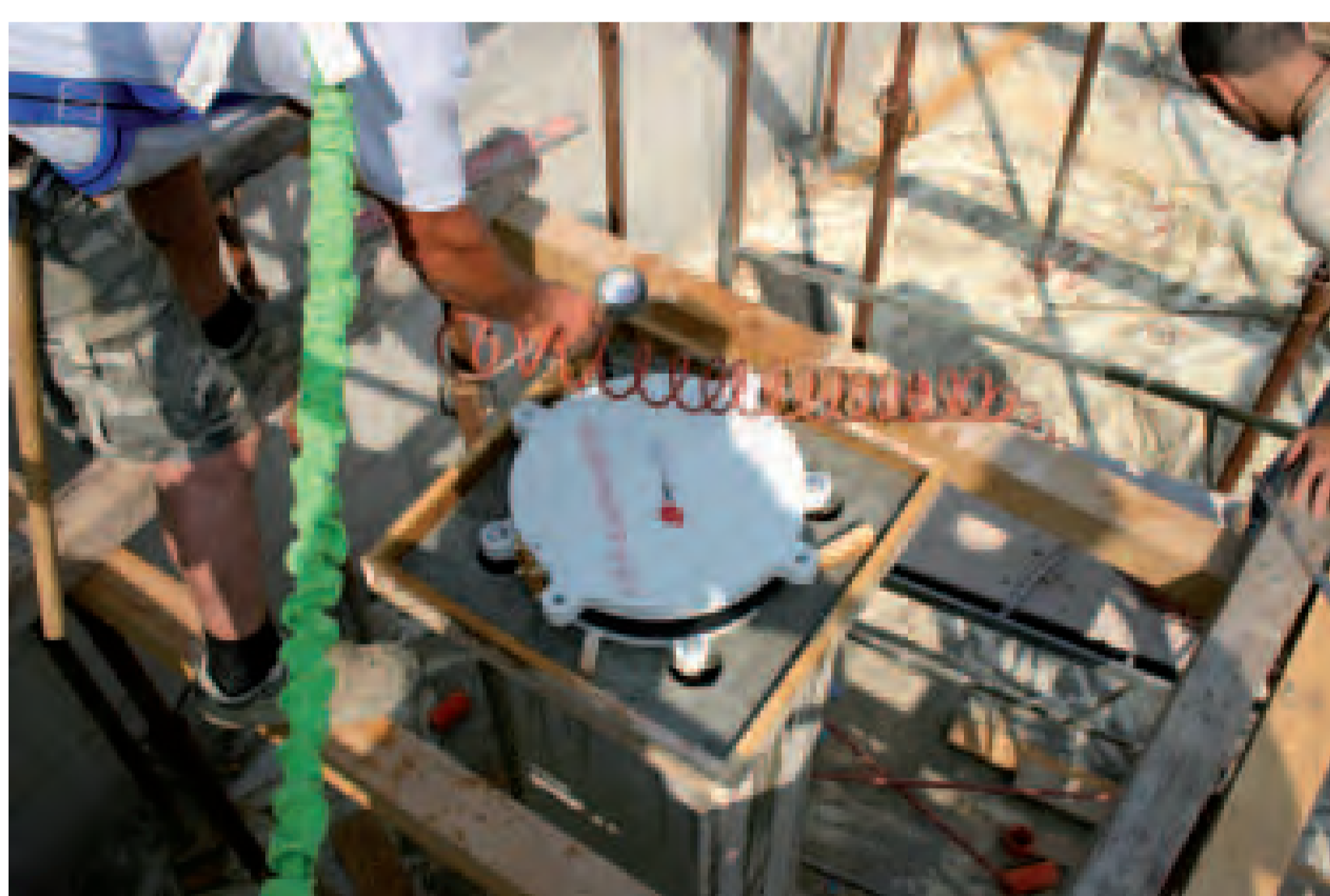
In alto da sinistra: - l'armatura del capitello, il pilastro con le sedi di alloggiamento, la movimentazione e l'inserimento della piastra
