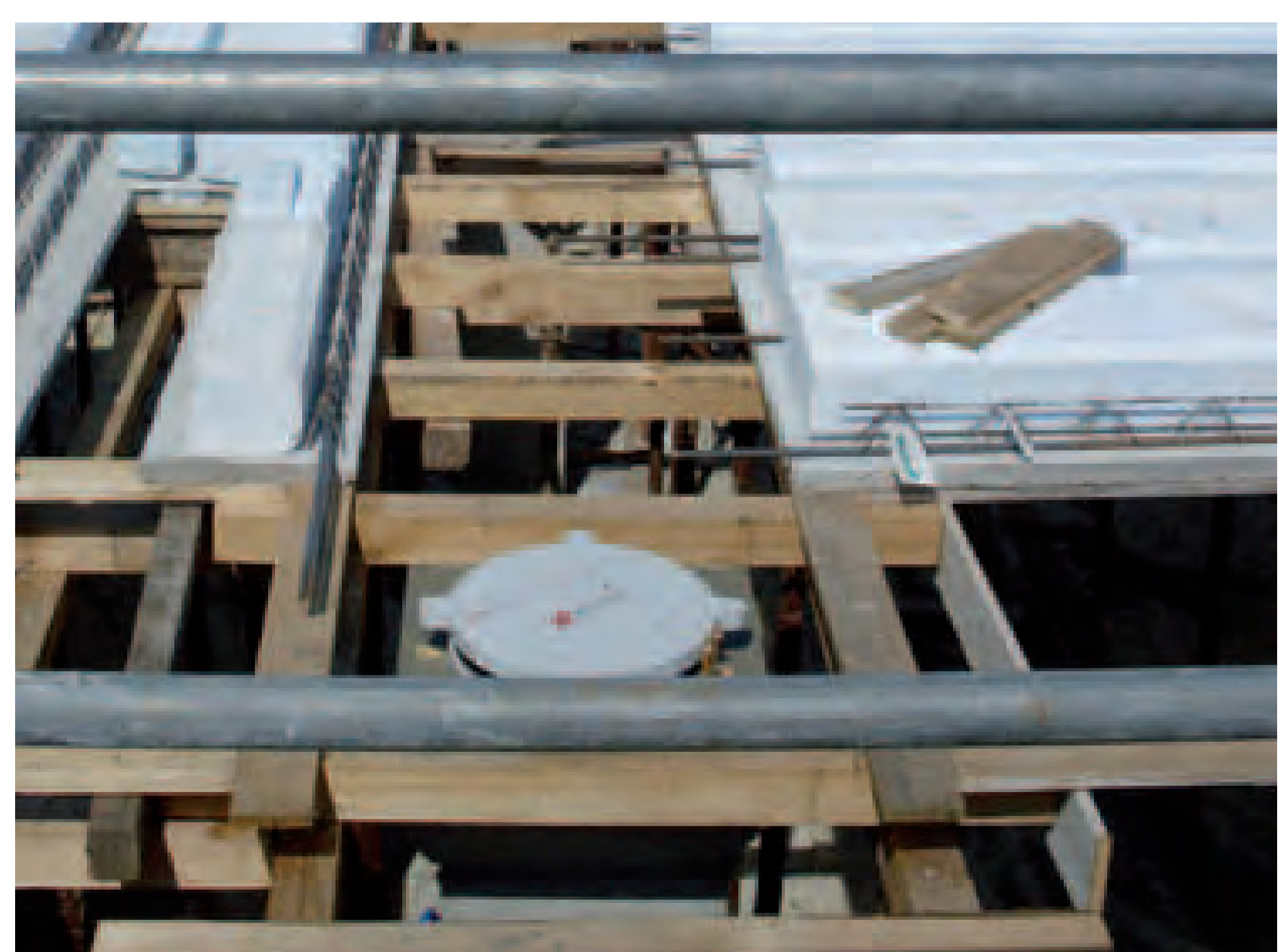
Sopra da sinistra: messa in bolla, pulizia dei fori di ancoraggio; getto
