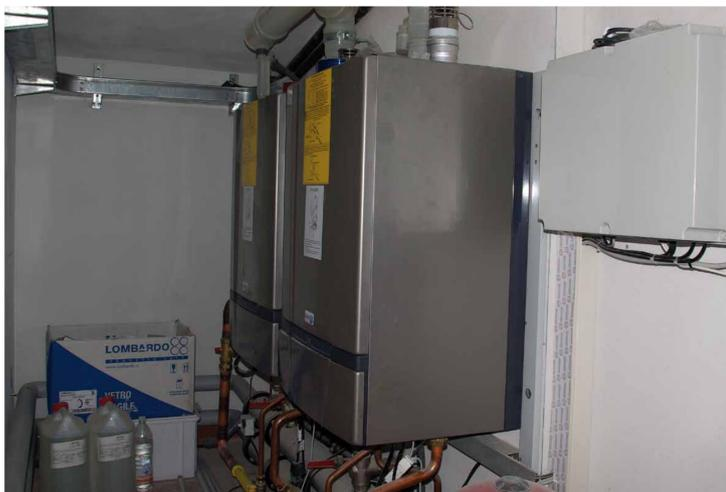
**L'impianto termico** è centralizzato con caldaia a condensazione e terminali a pannelli radianti con sistema di contabilizzazione singolo per ogni alloggio
