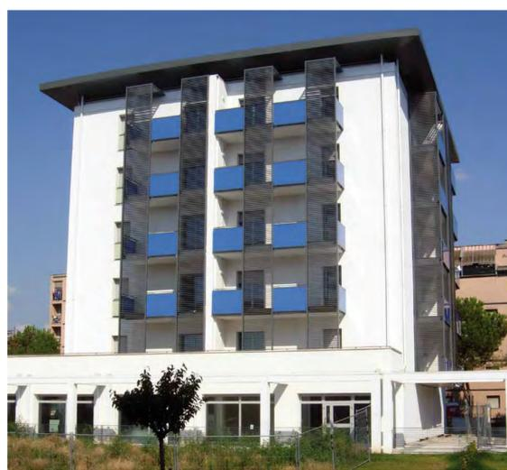
**Attraverso simulazioni** in situazioni limite (solstizi) e in condizioni intermedie (equinozi) è stato possibile studiare la corretta installazione dei frangisole rispetto ai fronti sud, ovest ed est ed il dimensionamento dei profili per massimizzare l'irraggiamento nei mesi invernali e ridurlo notevolmente nei mesi estivi
