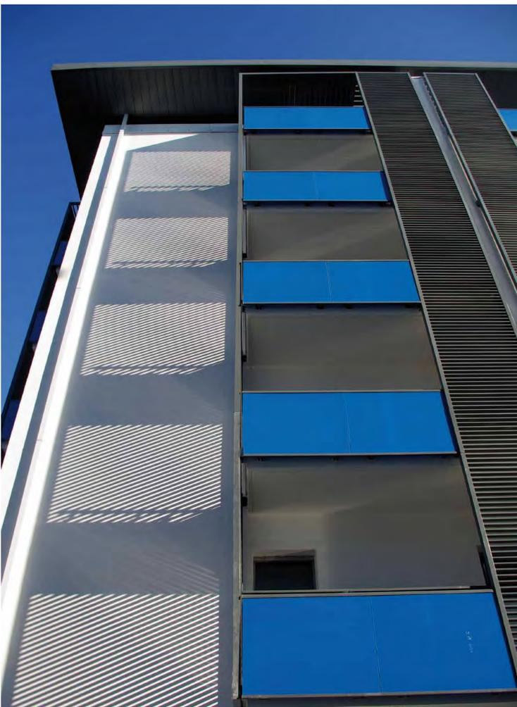
**I Brise-Soleil** realizzati in alluminio verniciato costituiscono la schermatura solare dei fronti.
