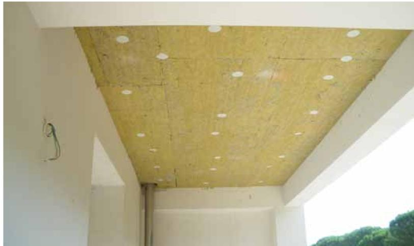
Isolamento a *cappotto* dell'intradosso dei solai aggettanti con lana di roccia  $\neq$  cm.5 e conducibilità 0,040 W/m K
