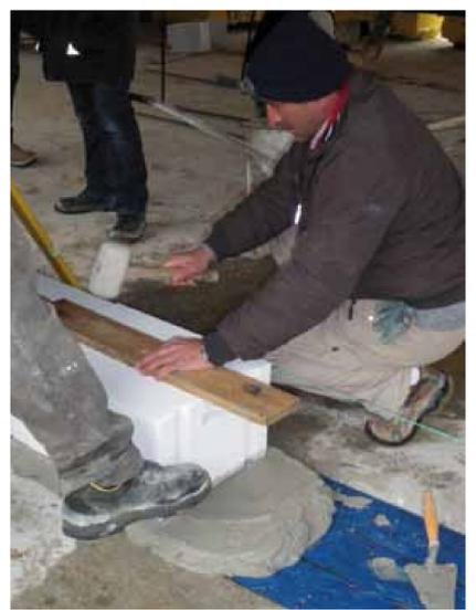
Tamponamento esterno con monoblocco in calcestruzzo cellulare autoclavato sp. 36,5cm
