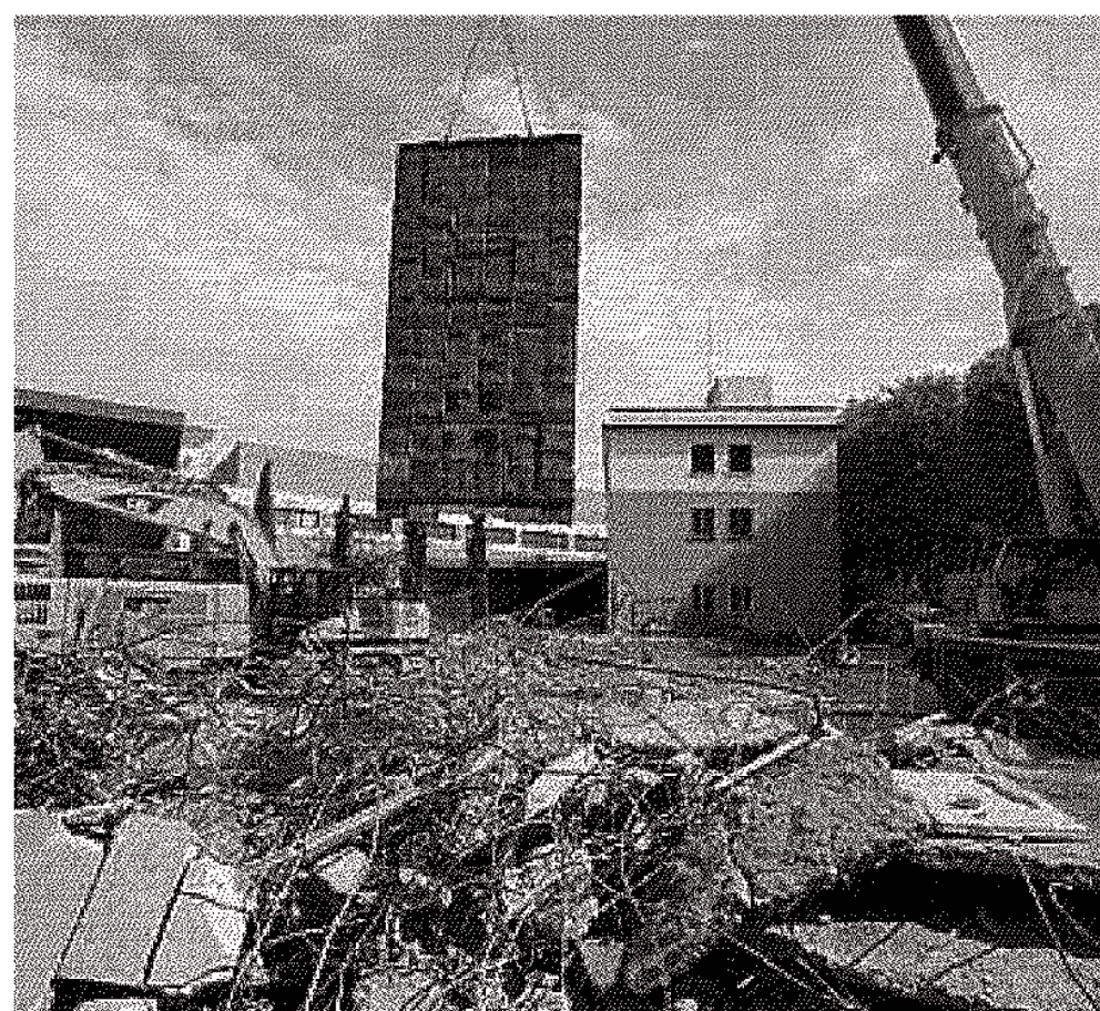
MACERIE Quel che resta dell'Ex Esselunga e del vecchio Cpa di viale Giannotti dopo l'intervento delle ruspe
