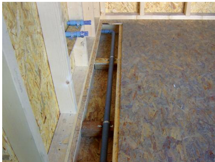
Installazione dell'impianto sanitario del bagno in stabilimento e passaggio delle tubazioni nella pavimentazione.
