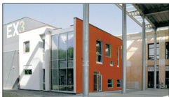
Casa Spa (ex Ater Firenze). La Iudoteca di Castorano a Firenze inaugura il 27 settembre con sistema costruttivo in legno Xlam è la prima parte del complesso di housing sociale di 45 alloggi. Progetto Marco Barone e Carlo e Matteo Casari
