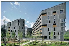
Istituto per l'edilizia sociale della Provincia di Bolzano. Sono stati consegnati il 21 settembre 96 alloggi su 136 del lotto EA2 nel quartiere Casanova a Bolzano. Gli altri 39 saranno consegnati a breve mentre 30 sono stati riservati al colto medio. Al quartiere, realizzato su maestroni degli olandesi Architekten Cie, manca ancora l'ultimo lotto l'EA5, 159 alloggi in quattro palazzine, che verrà consegnato entro l'anno. Progetto Cdm Architetti Associati con Paola Senta
