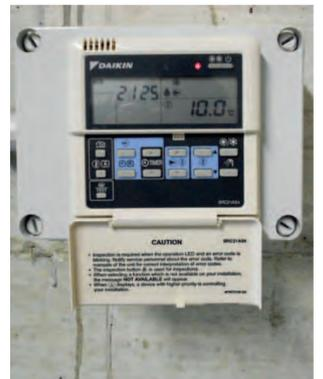
**Pannello di comando** della pompa di calore unità esterna
