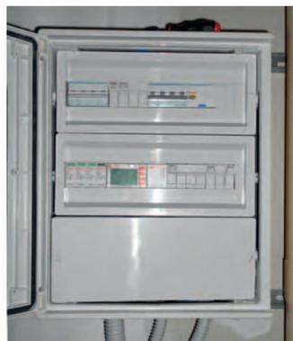
**Quadro elettrico** dell'impianto fotovoltaico
