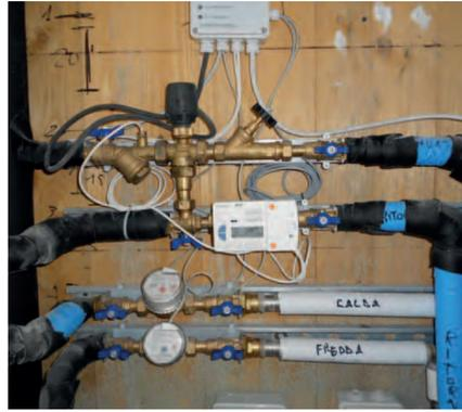
Ogni alloggio è dotato di **contabilizzazione del calore e dell'acqua sanitaria** tramite satelliti di utenza installati esternamente a ciascun alloggio, nel vano scale. Tramite rete M-Bus tutti i misuratori sono remotizzati fino al concentratore installato nel locale tecnico per l'acquisizione dei consumi e la ripartizione degli stessi.
