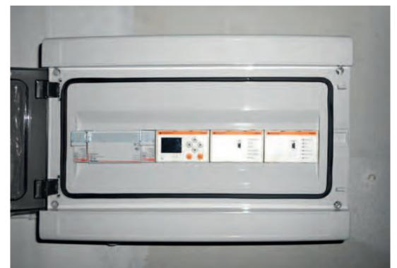
Concentratore **lettura contabilizzatori** con possibilità di tele lettura
