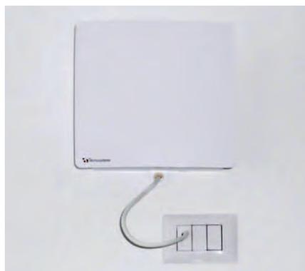
Ventilazione meccanica interna a ciascun locale realizzata con **aspiratore/estrattore da incasso** dotato di **recuperatore di calore**.
