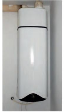
La produzione di acqua calda sanitaria internamente a ciascun alloggio è demandata ad uno **scaldacqua a pompa di calore** monoblocco da 110 litri.
