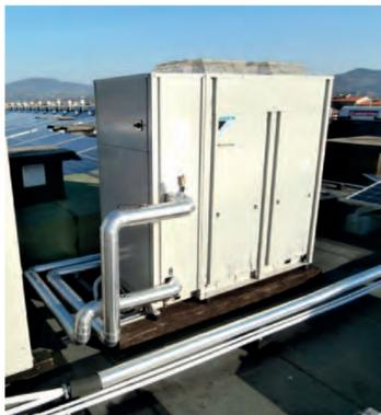
L'edificio è climatizzato con n° 3 **pompe di calore aria-acqua** (una a servizio di ciascun vano scale) poste sulla copertura piana dell'edificio. Potenza termica nominale 32,1 kW. Potenza frigorifera nominale 30,9 kW
