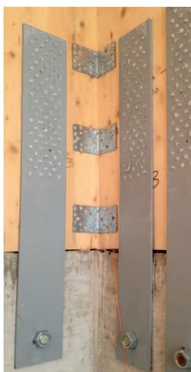
La sovrastruttura lignea viene collegata alla piastra in cemento armato (che può essere costituita dalla fondazione o dal solaio di piano terra) mediante piastre metalliche predisposte su cordoli in cemento armato estradossati. Gli spinotti vengono predisposti nel cordolo prima del getto del cemento armato, in modo da evitare che successivamente debbano essere praticati fori ed usate resine.
