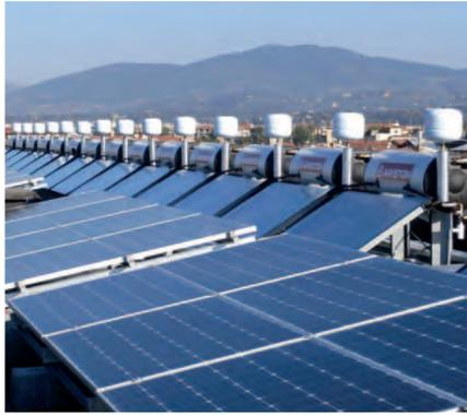
L'acqua fredda sanitaria in ingresso ai produttori autonomi interni a ciascun alloggio viene preriscaldata tramite un **impianto solare termico centralizzato** a circolazione naturale installato sulla copertura dell'edificio composto da n° 7 pannelli piani per ciascun vano scala.
